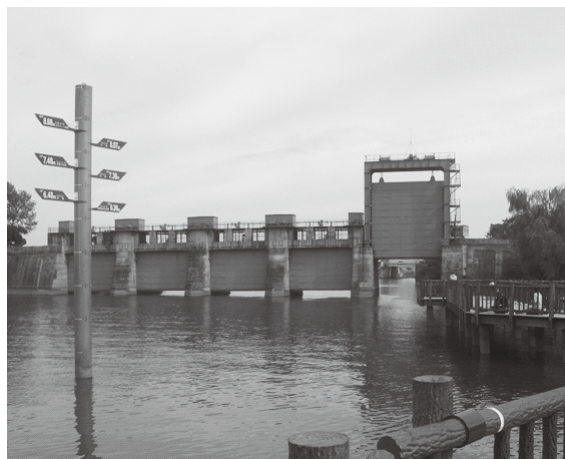
写真1 最近の荒川放水路開削工事で建設された岩淵水門
