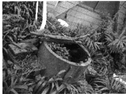
コンクリート製防火用水槽
