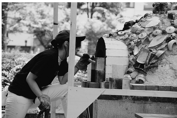
写真3 窯づくり：ピザ窯を作り、ピザを提供した。窯作りは、基礎工事から行う本格的なものだった。今後は学生の憩いの場として活用されていく予定である。
